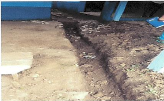
Foto 5: Cambio de torta de cemento y banqueta.
