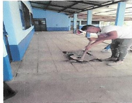
Foto 4: Cambio de piso de corredor
