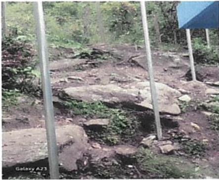
Foto 3: Reparación de malla de circulado del centro educativo.
